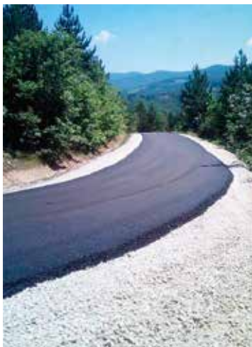
Nieuwe asfaltweg naar Priboj. http://priboj.sns.org.rs
